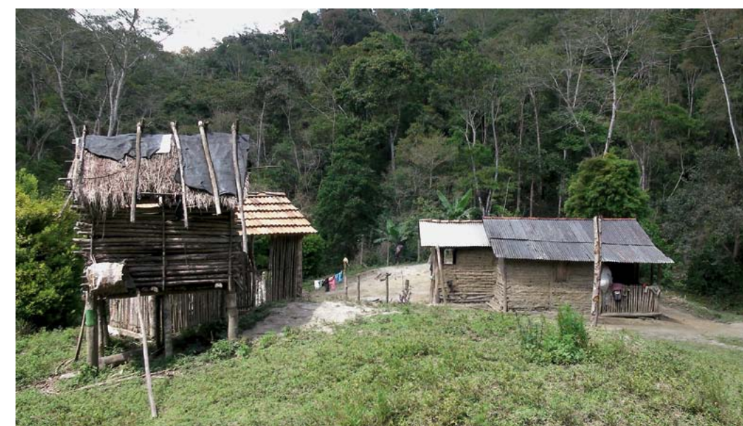
Casa de pau-a-pique e paiol no Quilombo Bombas. © Acervo ISA, 2010
