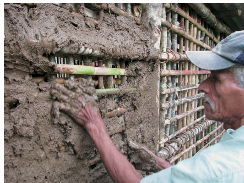
João Santos da Rosa barreiando a Casa de Taipa. © Juliana Ferreira/ISA, 2011
